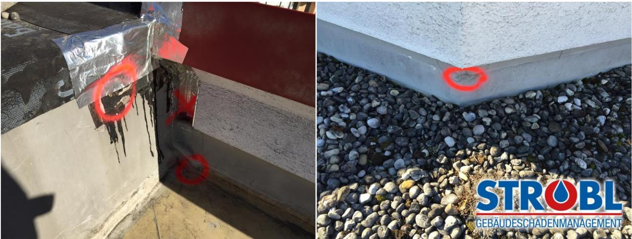
**Die Anwendung im Beispiel:** Über den Rauchgassimulator wird das Rauchgas unter die Abdichtung eingebracht. Somit verteilt sich der eingebrachte Rauch in der Dämmschicht und tritt an den Schadstellen wie Rissen, Anbindungen oder im Bereich der Attika aus. Anschließend werden die Schadstellen für die Schadensbehebung markiert.
